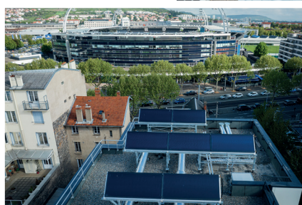
Capteurs solaires en toiture
